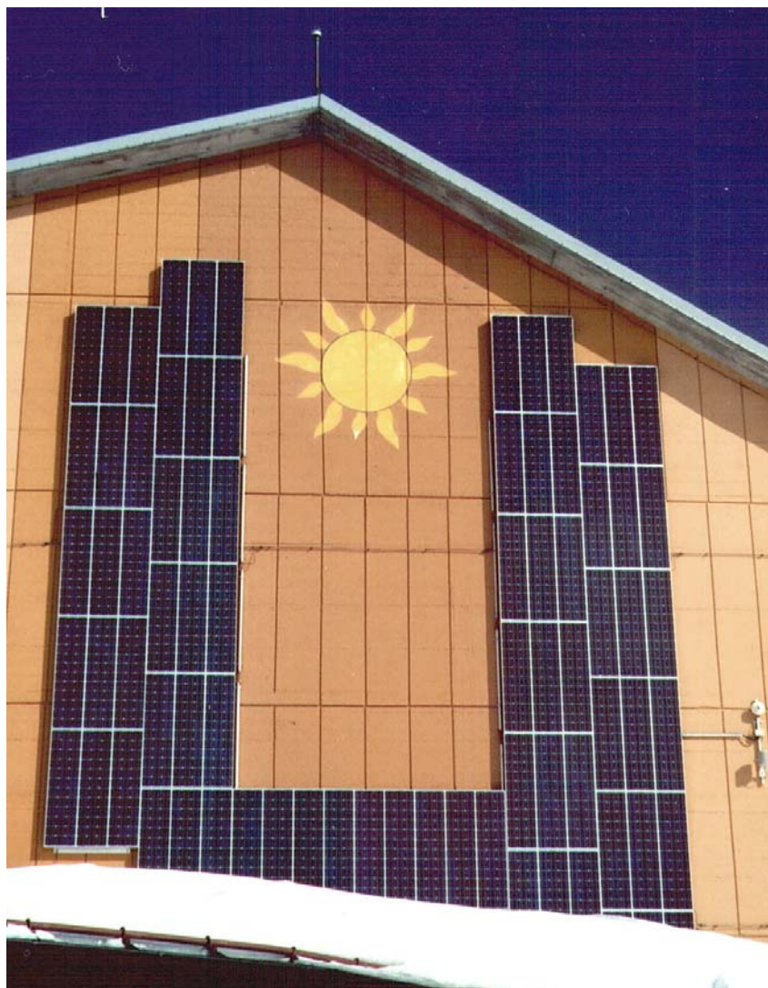
Solargenerator der PV-Anlage (4,134 kWp) an der Fassade der Mittelstation Birg der Schilthornbahn auf 2670 m. (Bild: Heinrich Häberlin, Buch Photovoltaik [2])
