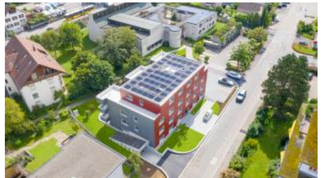
2-farbige Fassade mit grauen Modulen (70% Ertrag) und PV Dachanlage
