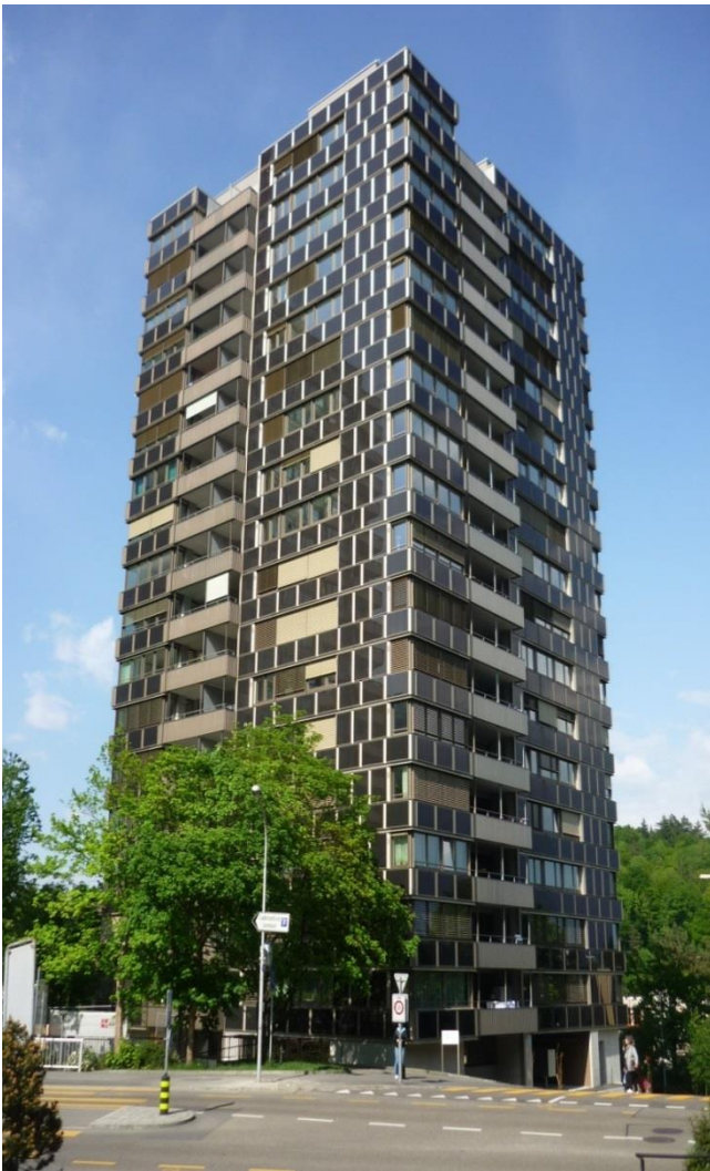
Sihlweidstrasse 1 mit PV Fassade (2011)
