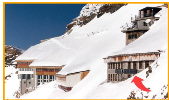
PV Fassade Jungfrauoch des PV Labors von 1993 – bis 1'500 kWh/ kWp Ertrag
