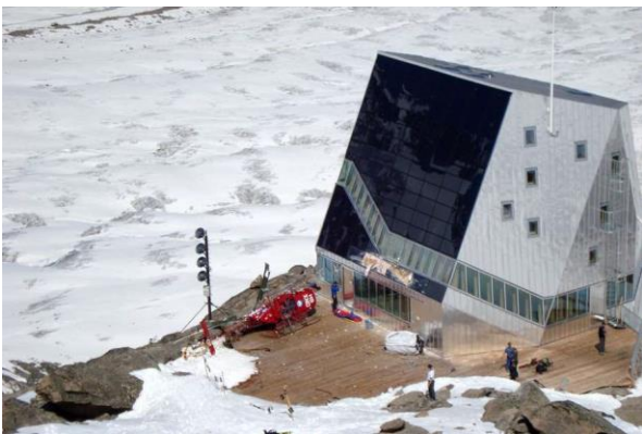
Ersatzmodule nötig: Helikopter beschädigt PV Fassade
